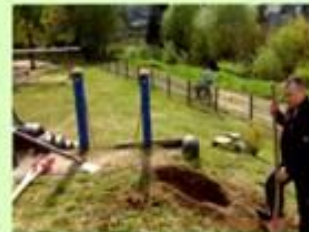
Ausschachtarbeiten am Kinderspielplatz zur Montage eines Sonnensegels
