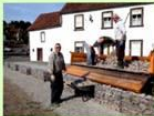
Erstellen von Gabionen am Berndt'schen Gelände
