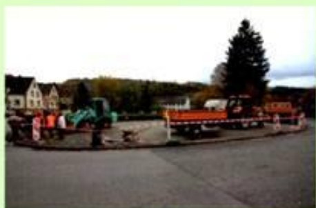
Erste Arbeiten 2013: Rückbau der alten Pflastersteine
