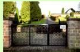
Renovierungsarbeiten an der alten Leichenhalle und an sämtlichen Zugangs-toren zum Friedhof, Leistung eines Einzelnen!
