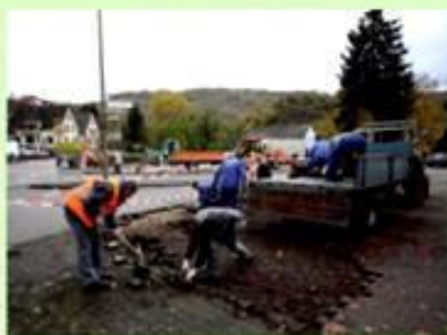
Erste Arbeiten 2013: Rückbau der alten Pflastersteine
